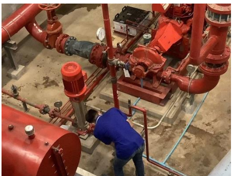
รูปที่ 2.1-15 เจ้าหน้าที่ตรวจเช็คระบบป้องกันอัคคีภัย (ระบบถังเก็บน้ำดับเพลิง)
