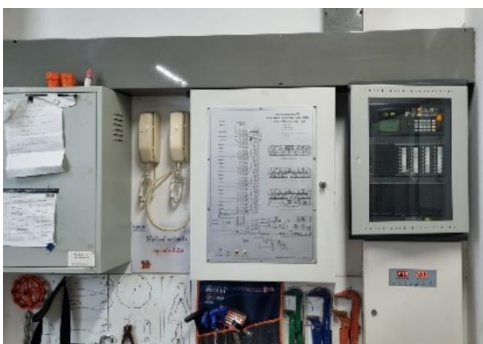
แผงควบคุมระบบ รูปที่ 2.1-14 ระบบป้องกันอัคคีภัย
